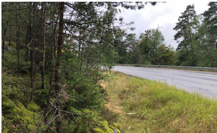
Avrinning sker diffust till ett svackdike (vägdike) som går längs Skarpövägen (norra delen av planområdet) och därefter leds dagvattnet vidare i östlig riktning
